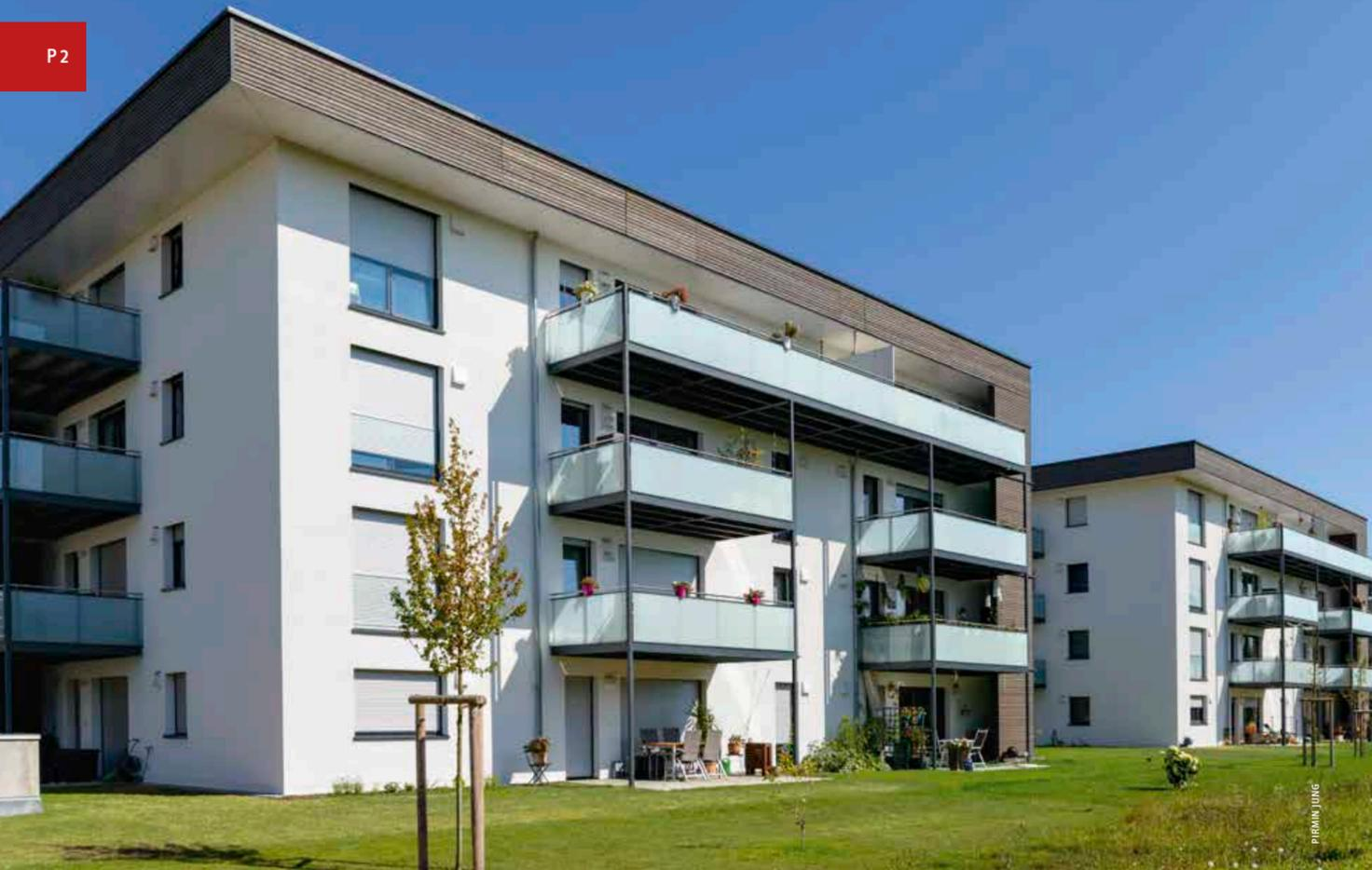
▲ Geschlossene Fassadenelemente weisen eine Holzfront auf, mit Fenstern durchsetzte Bereiche wurden verputzt
