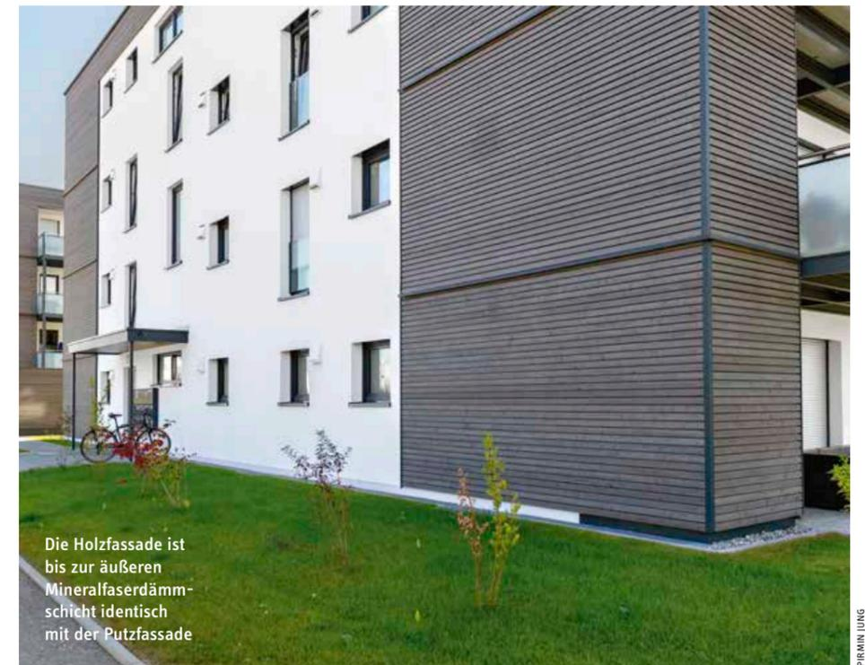
Die Holzfassade ist bis zur äußeren Mineralfaserdämmschicht identisch mit der Putzfassade
