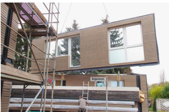
Hier fehlen noch die Fenster. Auch diese haben die Zimmerer noch in der Halle eingesetzt, bevor die Elemente dann auf der Baustelle montiert wurden.
